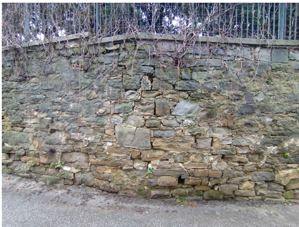
Vista frontale del muro
