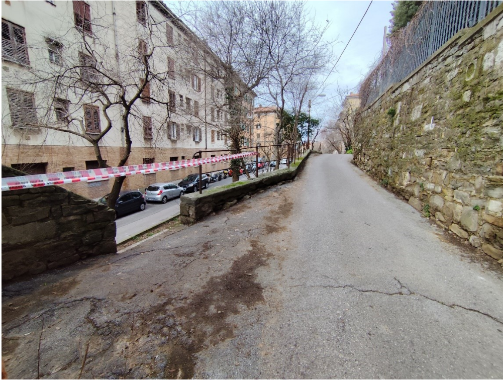
Vista laterale del muro
