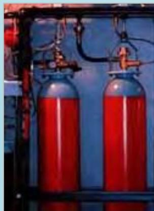
La pressurizzazione è ottenuta mediante un gas inerte (azoto, anidride carbonica).
