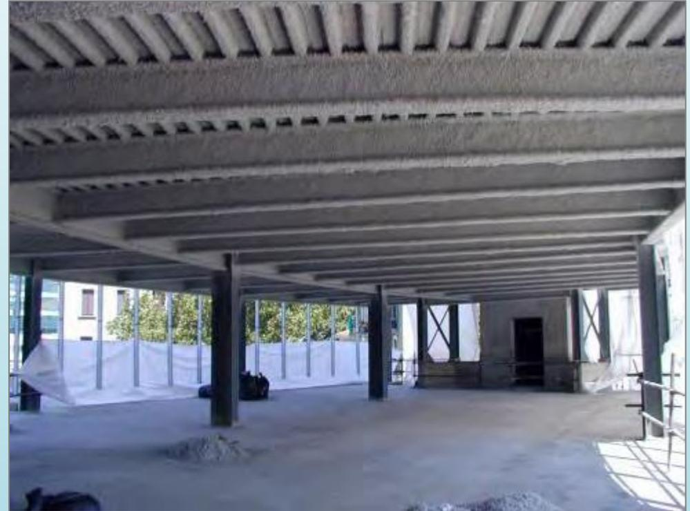
Questi elementi protettivi ininfiammabili, possiedono capacità isolanti al calore, con la particolarità di rigonfiarsi, schiumando, generando uno strato isolante in caso di alte temperatura.
